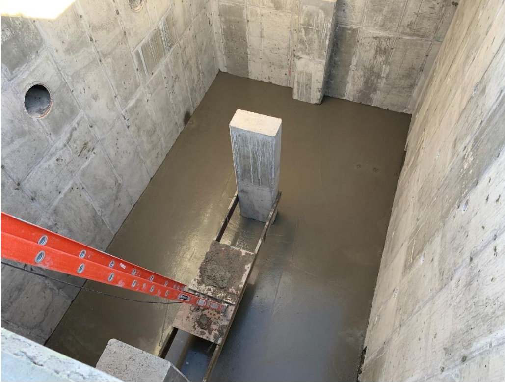
Concrete Pour Flocc Basin 1-09-20
